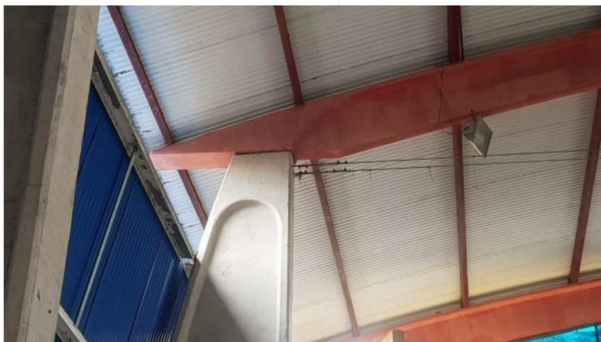
Figura 8 - Detalhe ligação entre viga e pilar de concreto armado
