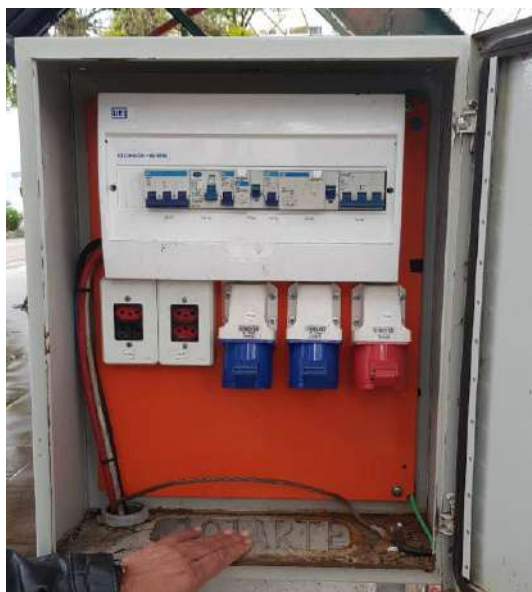
Figura 03: Caixa existente internamente (Fonte: Amunesc)
