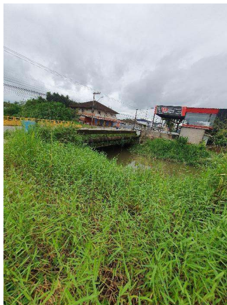
Foto 29: Trecho 35 trecho sob via - ponte
