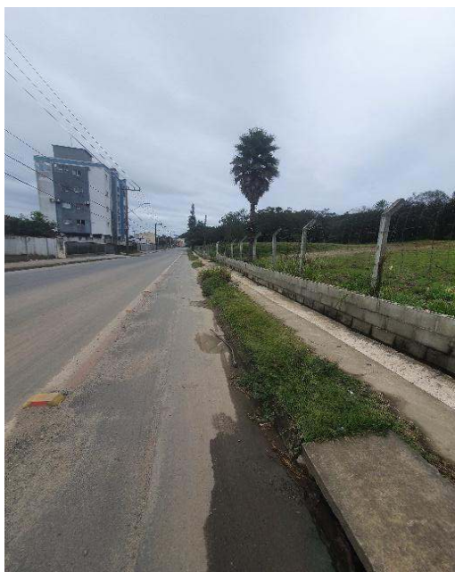
Foto 26: Trecho 31 - fechado em via pública
