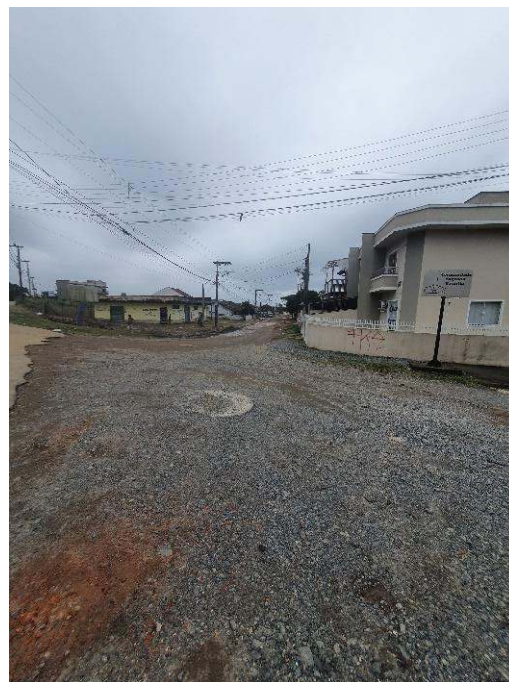
Foto 25: Trecho 32a – trecho fechado em via pública
