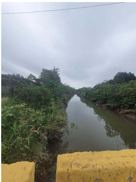
Foto 28: Trecho 34d - aberto com árvores isoladas
