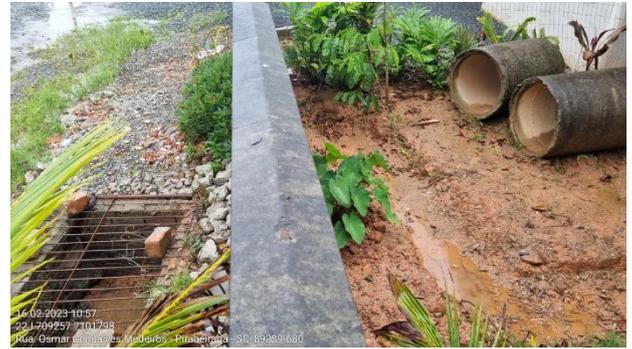
**Figura 54:** Fim do trecho 69 (tubulado sob via) – início do trecho 70 (tubulado entre lote).
