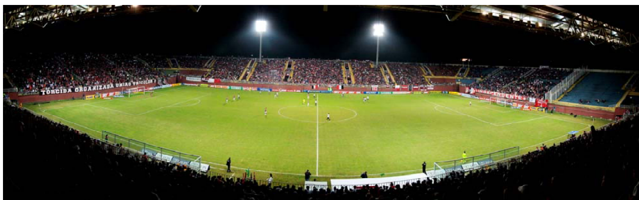
Figura 41: Arena Joinville Fonte: Secom
