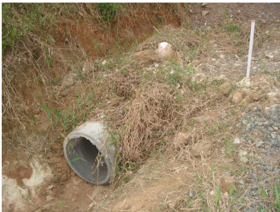
Figura 06: Execução da drenagem já executada e coberta. Fonte: Autor, 2016
