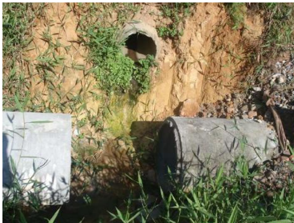
Figura 07: Espera para execução da caixa de drenagem na Rua Jaó. Fonte: Autor, 2016.
