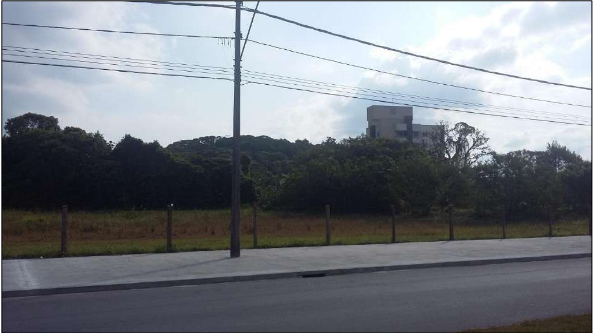
Figura 56: Rede elétrica passando pelo imóvel em estudo.
