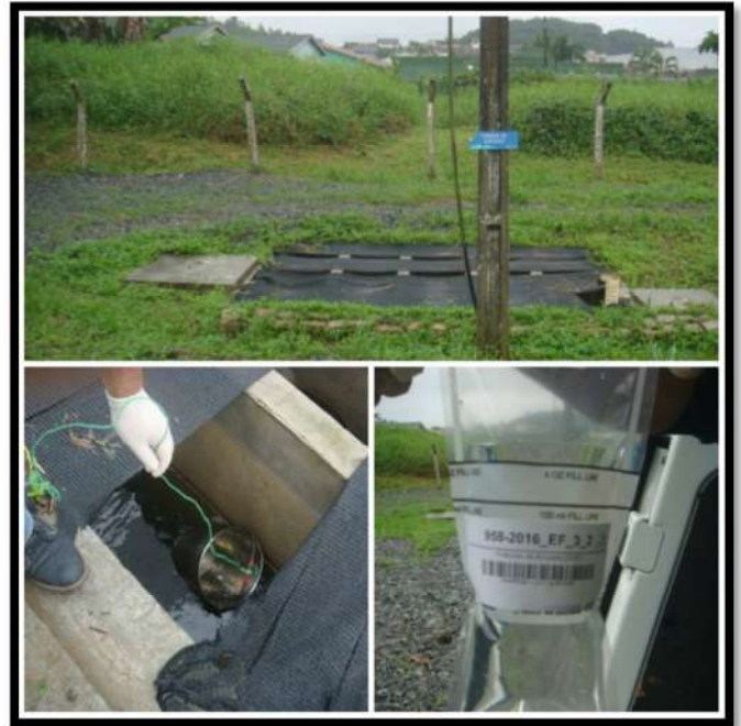
Saída ETE Profipo
