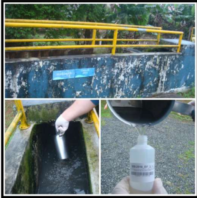
Entrada ETE Profipo
