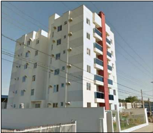
Figura 73 – Edificação com 6 andares.
