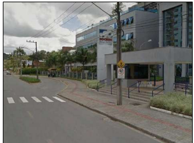
Figura 82 – Sinalização para travessia dos alunos.
