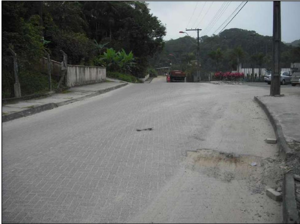
*Figura 13: Rua Tupy com pavimento do tipo paver.*
