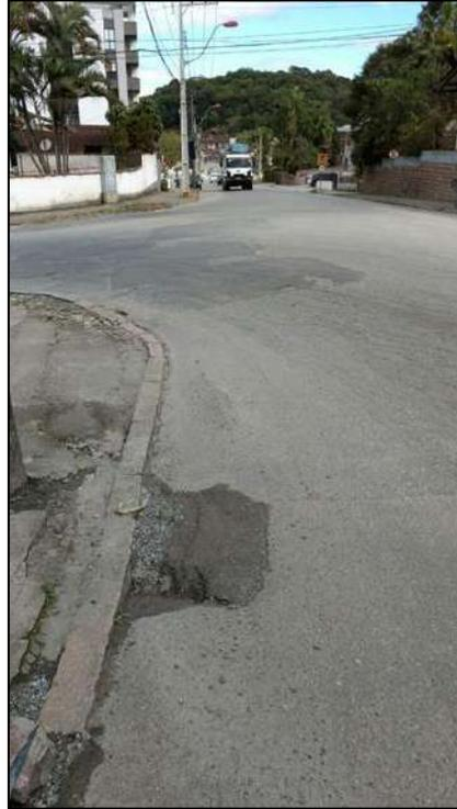
Figura 108: Rua Tupy esquina com O. Doerffel. Notar a falta de faixas de pedestres e as falhas no pavimento da rua.
