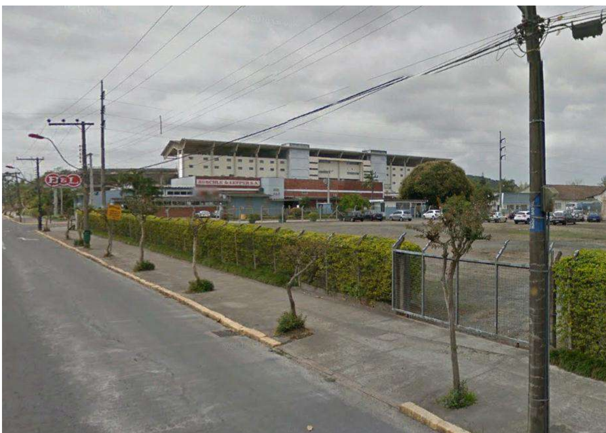
Figura 63: Rua principal que liga ao empreendimento com blocos de concreto.
