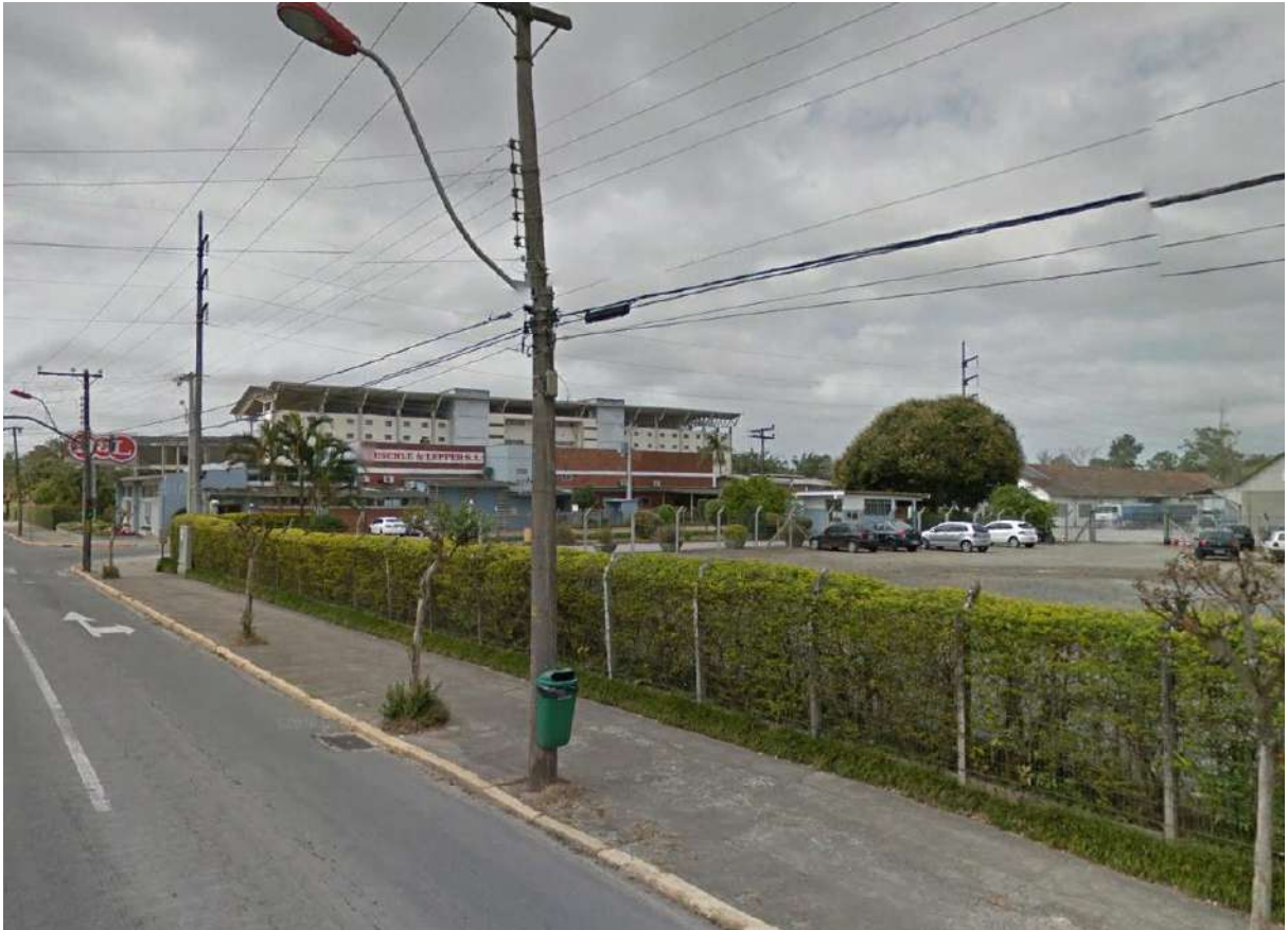
Figura 62: Rede elétrica passando pelo imóvel em estudo.
