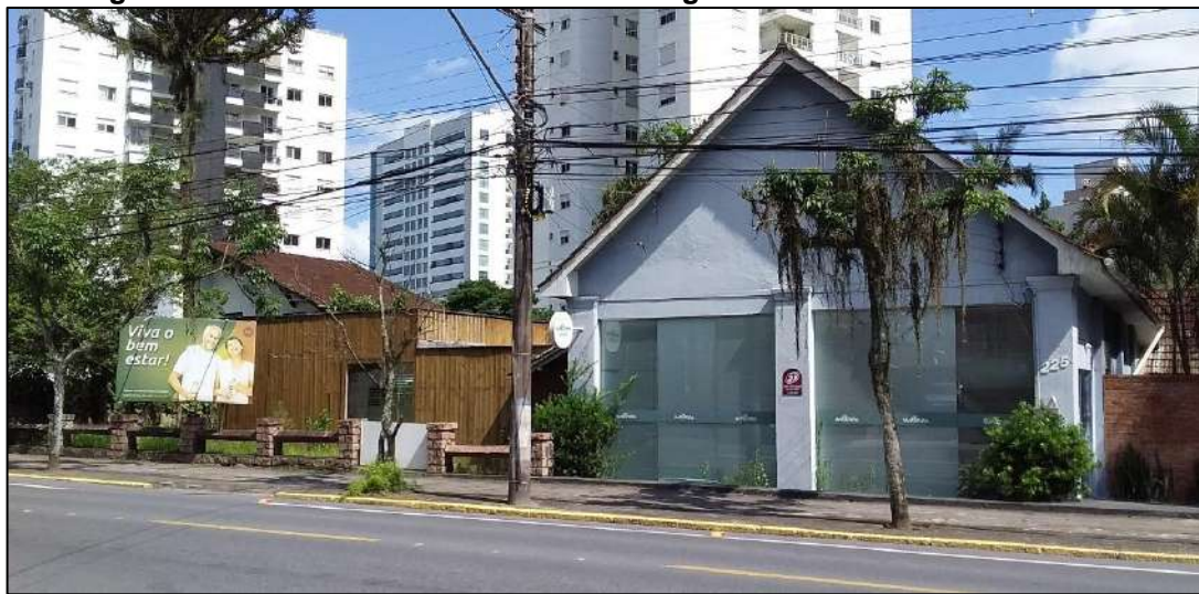
Figura 51 - Rede de abastecimento de energia elétrica na Rua Otto Boehm.
