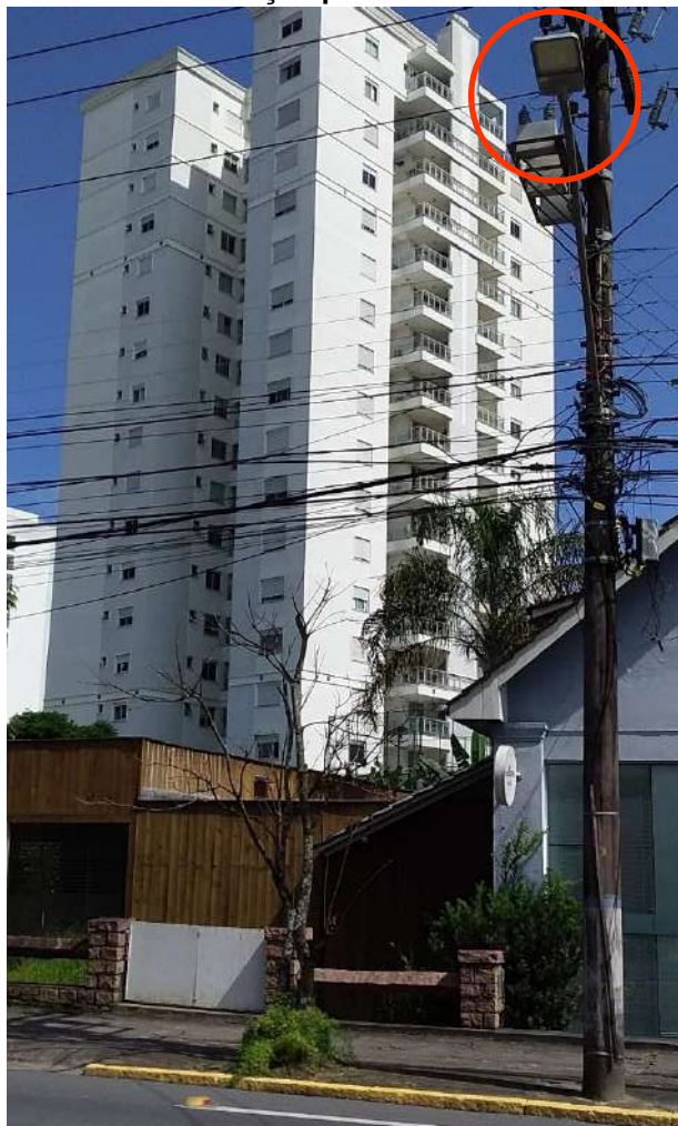
Figura 55 – Sistema de iluminação pública localizado na Rua Otto Boehm.
