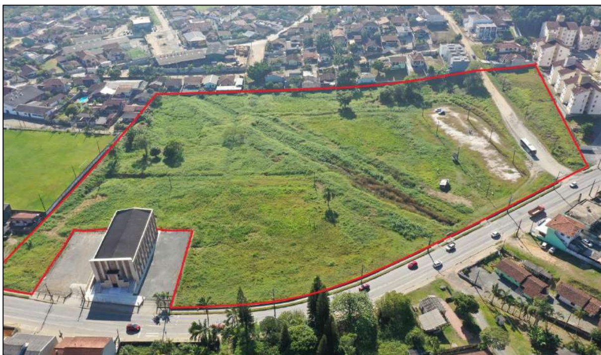
Figura 8. Delimitação e caracterização da vista frontal do imóvel em estudo e seu respectivo uso. Fonte: DBio, 2021.
