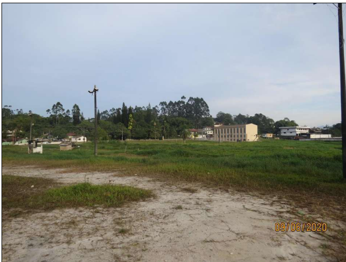
Figura 52. Rede elétrica passando pela área de influência do imóvel em estudo. Autor: DBio, 2020.
