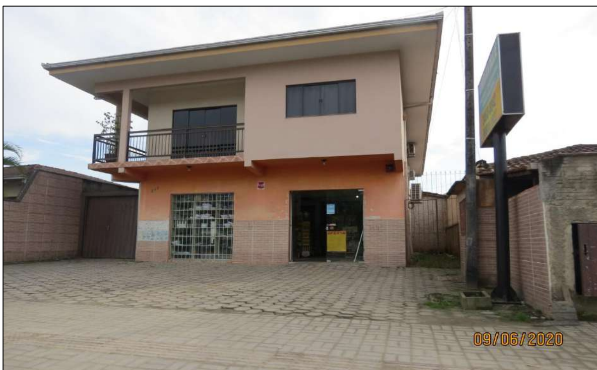
Figura 45. Empreendimento de uso misto, multifamiliar. Fonte: DBio, 2020.
