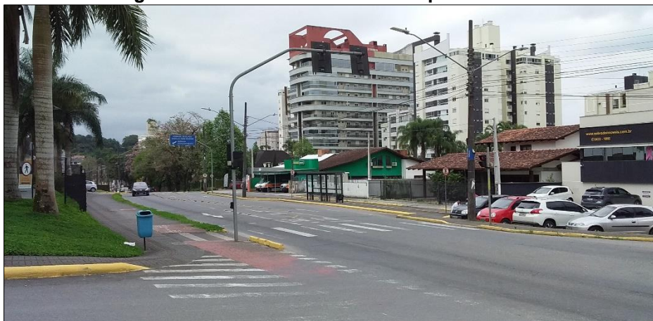
Figura 59 - Vista da Rua Camboriú pavimentada.
