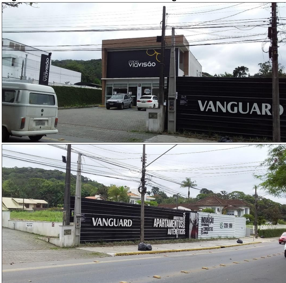
Figura 56 - Rede de abastecimento de energia elétrica na Rua Camboriú.
