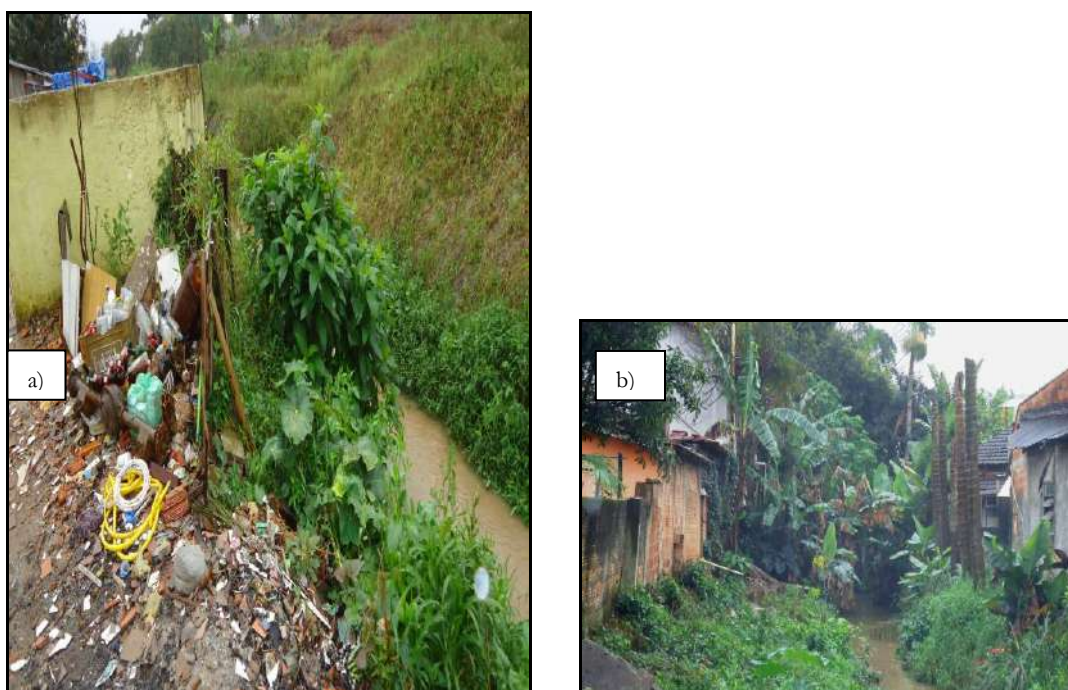
Figura 4.24 – Rio Bupeva: a) Disposição inadequada de resíduos. b) Ocupação nas margens.
