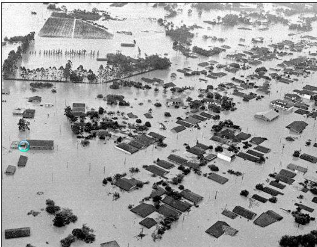
Figura 4.15 - Inundação de 9 de fevereiro de 1995 - Rompimento da barragem do Rio Cubatão do Norte. Fonte: Silveira et al. (2009)
