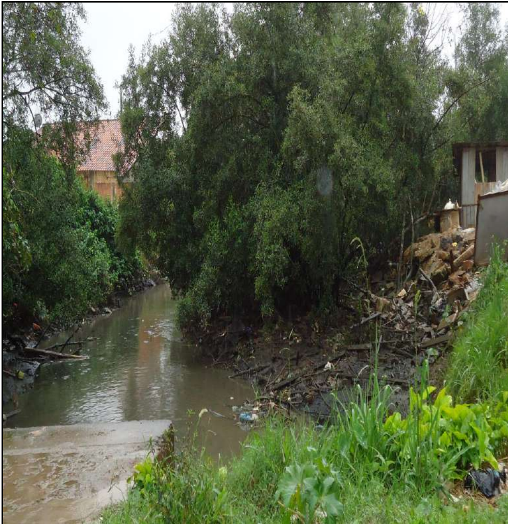
Figura 4.27 – Construção irregular e depósitos de construção sobre o mangue.
