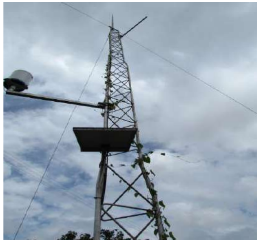
Figura 5.6.1 Estação Hidrológica - Unidade de Obras
