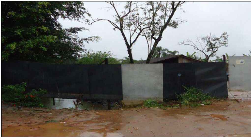
Figura 4.26 – Irregularidade encontrada: Morador fechou acesso ao rio Bupeva.
