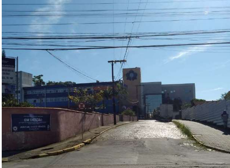
Figura 31 - Rede de abastecimento de energia elétrica na Rua Frederico Ponick.
