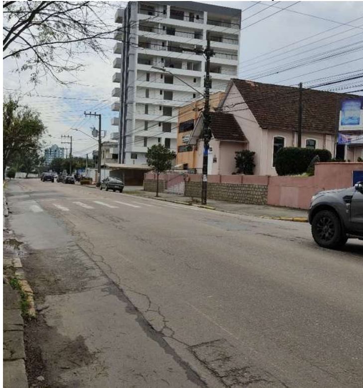
Figura 34 - Vista da Rua Dona Francisca pavimentada.
