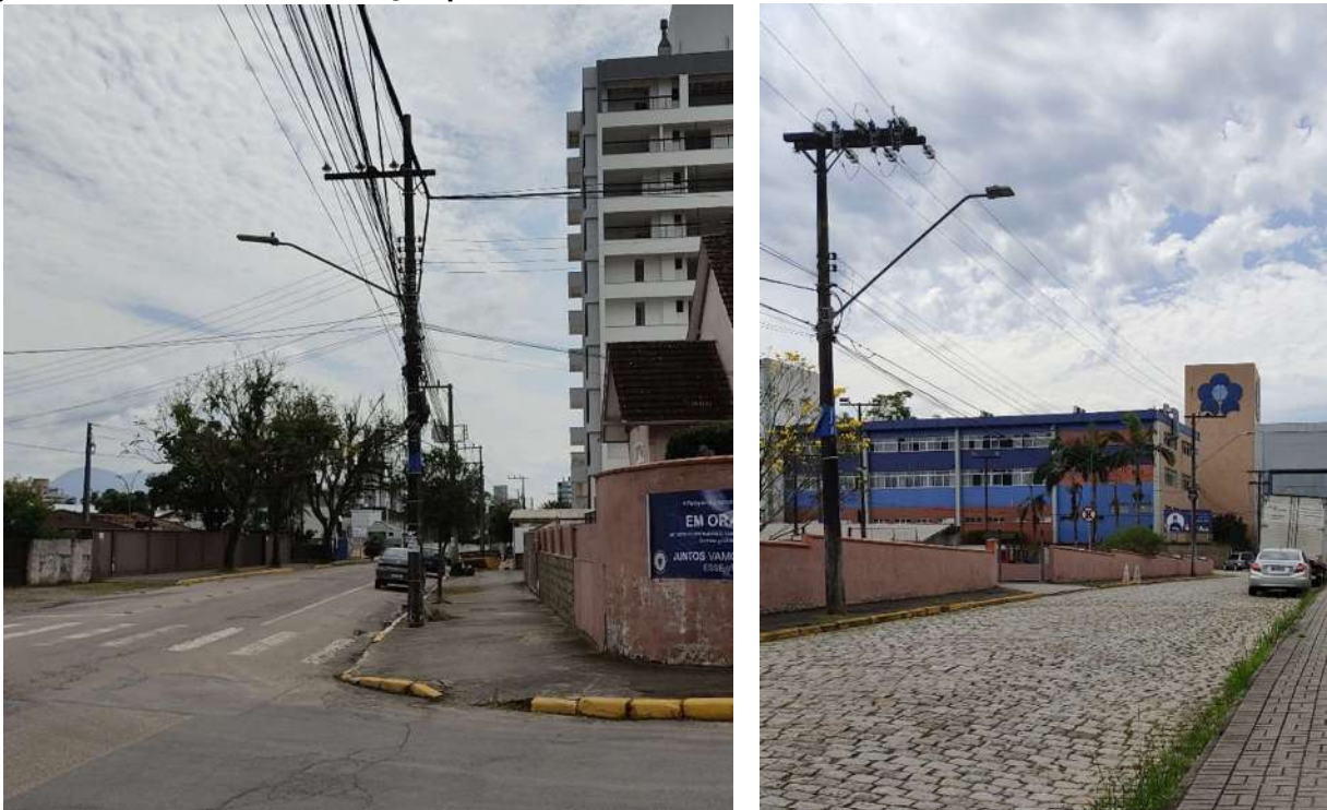
Figura 37 – Sistema de iluminação pública localizado na Rua Dona Francisca e Rua Frederico Ponick.
