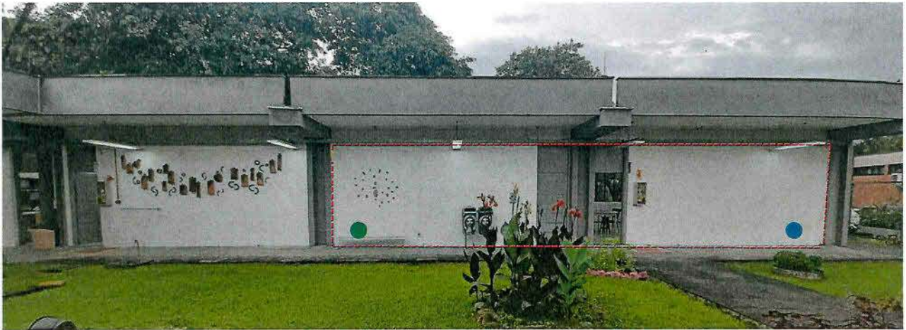
Foto 14 | Parede Salas 25 e 24
