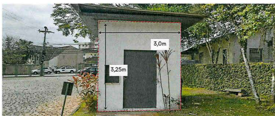
Foto 26 | "Casinha" Subestação lateral (com medidas)
