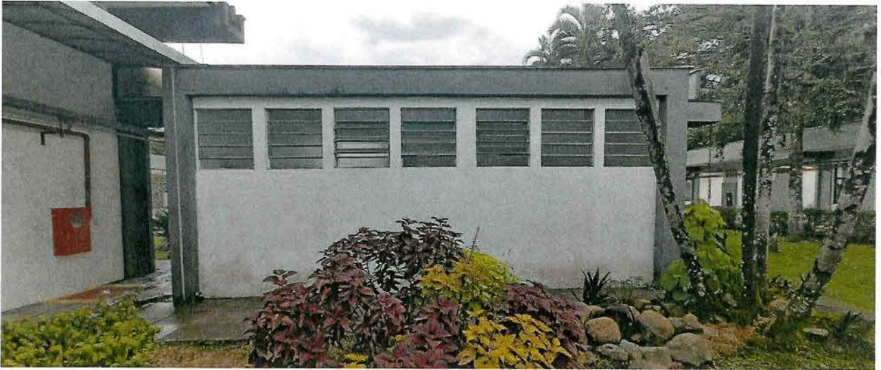
Foto 29 | Parede Frente do Auditório.
