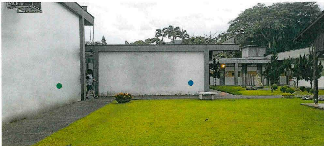
Foto 10 | Paredes Externa da Galeria e Sala 05
