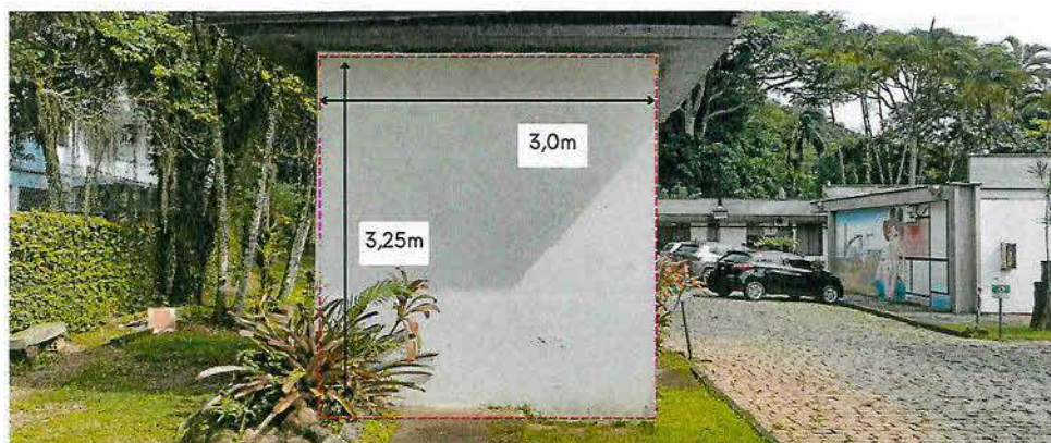
Foto 28 | "Casinha" Subestação lateral (com medidas)
