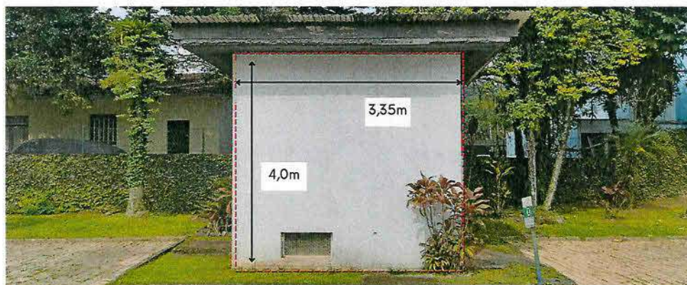
Foto 27 | "Casinha" Subestação Frente (com medidas)
