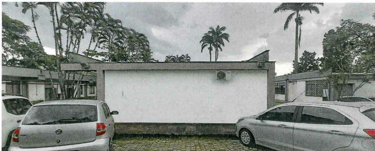
Foto 21 | Parede fundos Sala 06
