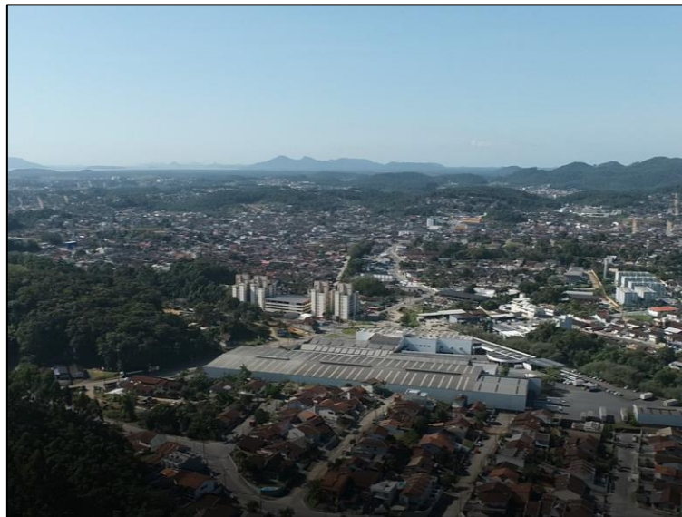
Figura 19. Vista no sentido leste da All, fragmentos florestais em meio à área urbana com ocupação densa.
