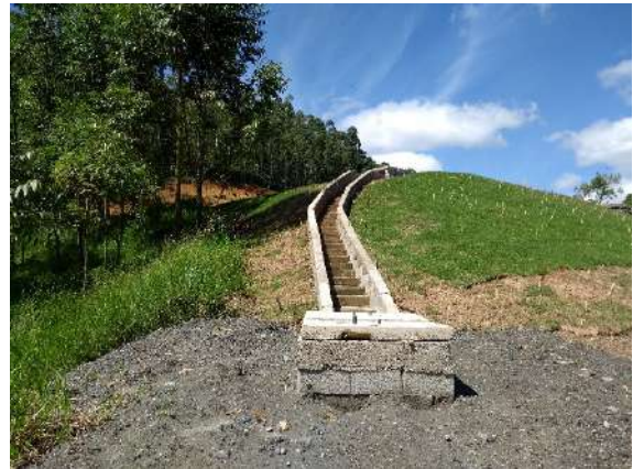
Foto 2-90: Mecanismos de proteção de encosta com escada hidráulica, caixa coletora e plantio de gramíneas. Fonte: Acervo Dossel, 2019.
