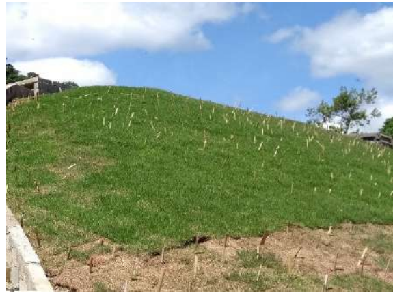
Foto 2-100: Encosta sendo recuperada com plantio manual de gramíneas na área de estudo. Fonte: Acervo Dossel, 2019.
