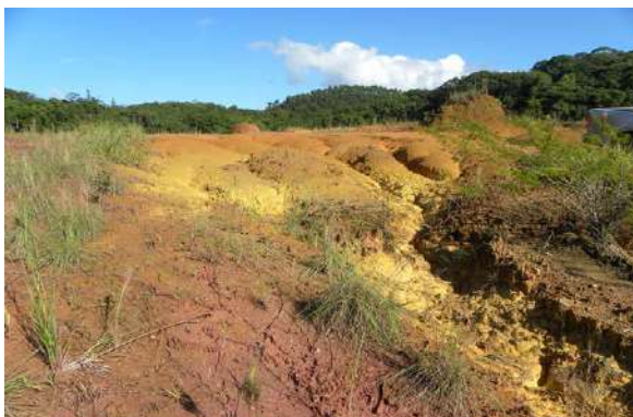
Foto 2-81: Evidência de erosão rasa passando a profunda em terreno de baixa declividade natural, condição favorecida pela remoção da capa de solo superficial (ação antrópica), exposição da rocha saprolítica frágil e concentração de águas pluviais sobre o terreno. Registro realizado na região de Corticeira, município de Guaramirim/SC.22 J 704895 m E 7073868 m S.
