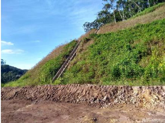
Foto 2-91: Estabilização de taludes em corte de rodovia na área de estudo, com sistemas de condução do fluxo superficial, dispersores de energia e vegetação. Fonte: Acervo Dossel, 2019.
