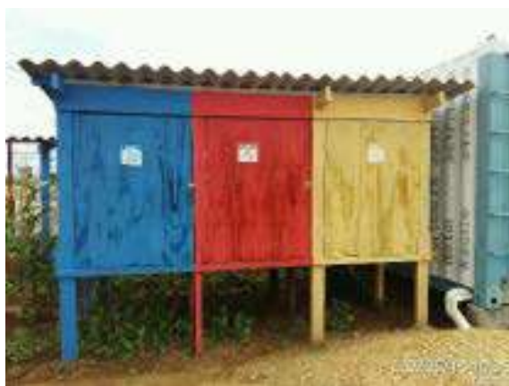
Foto 2-8: Baias para armazenamento temporário de resíduos. Fonte: Acervo CYMI, 2019.
