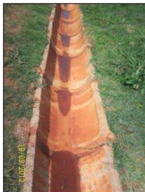
Foto 2-5: Calha meia de sistema de drenagem instalado em área de subestação. Fonte: Acervo Dossel, 2012.
