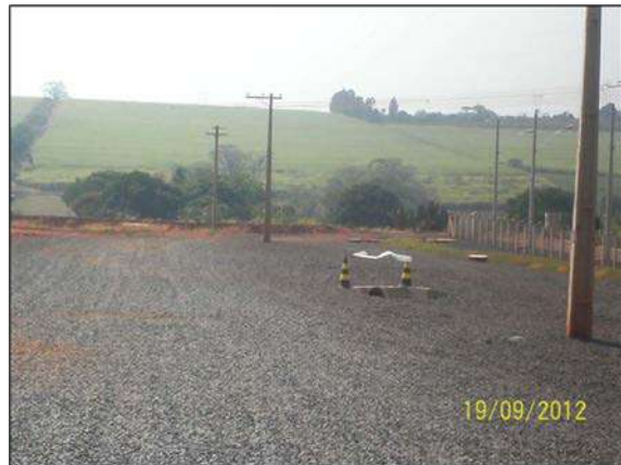
Foto 2-2: Revestimento de acesso com brita. Fonte: Acervo Dossel, 2012.
