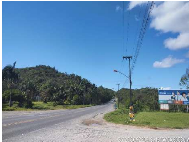
Foto 10-20: SC 108, iluminação pública e ponto de ônibus.
