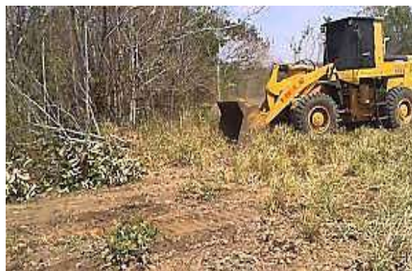
Foto 6-13: Pá carregadeira de direção com equipamento de terraplanagem. Fonte: Google, 2020.
