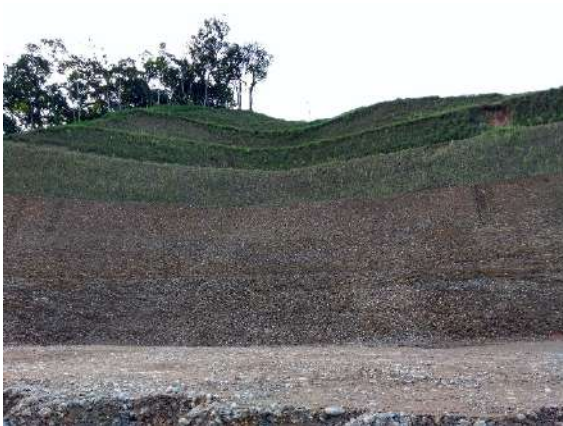
Foto 2-89: Proteção de taludes com sistema de terraços e gramíneas. Fonte: Acervo Dossel, 2019.
