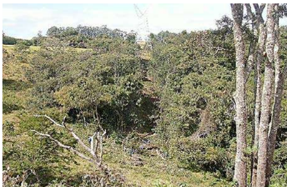
Foto 6-2: Exemplo de supressão na faixa de serviço (vão entre torres).
