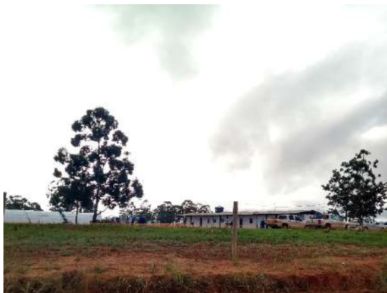
Foto 2-95: Canteiro de obra implantado próximo a um centro urbano. Fonte: Acervo Dossel, 2019.
