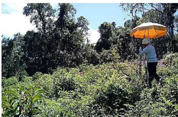
Foto 5-1: Marcação prévia do alinhamento da faixa de serviço (vão).
