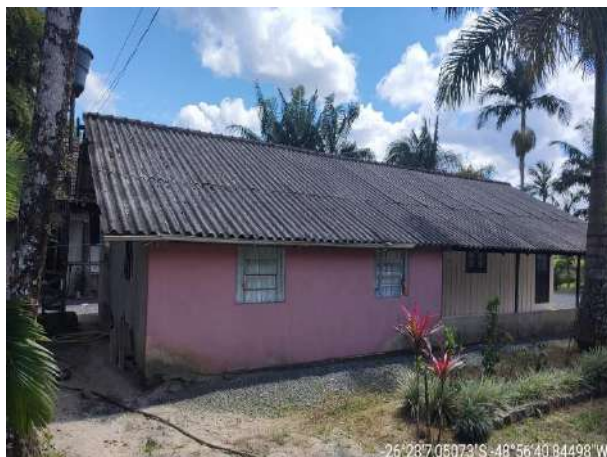
Foto 10-9: Casa térrea mesclada com alvenaria e madeira.
