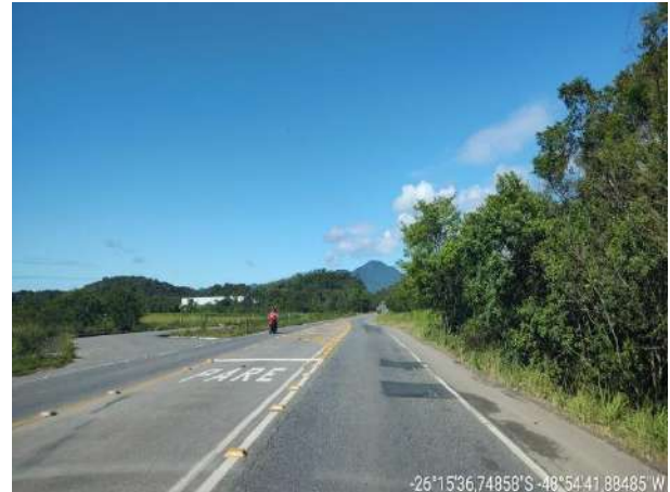
Foto 10-21: SC 108, via sinalizada em boas condições de tráfego.
