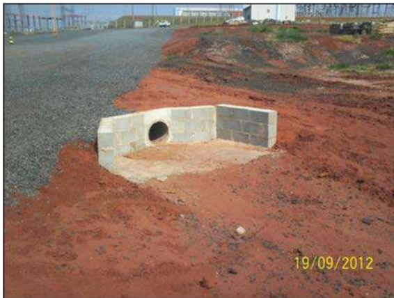
Foto 2-1: Dispositivo de drenagem no acesso à Subestação. Fonte: Acervo Dossel, 2012.
