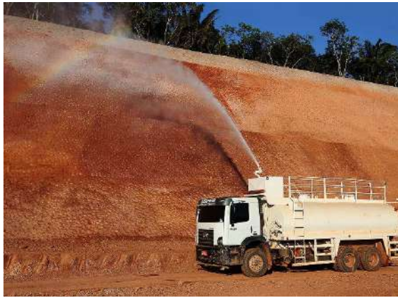
Foto 2-99: Técnica de hidrossemeadura aplicada em corte de talude. Fonte: http://fibraztech.com .
