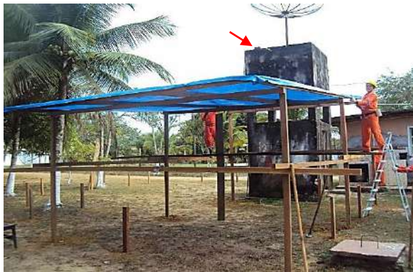
Foto 2-63: Construção da área coberta, semiaberta, de uso geral, apontando caixa de água próxima.
