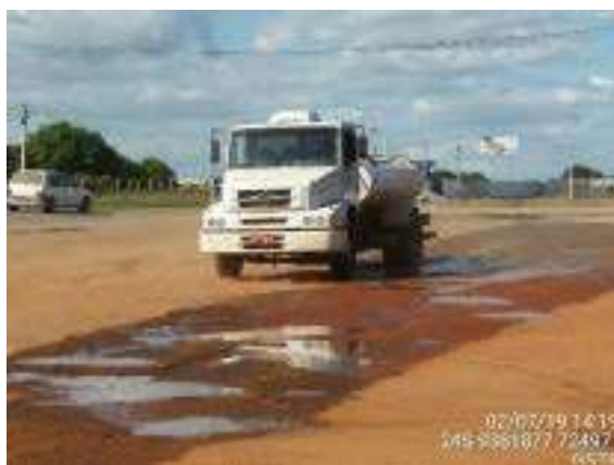
Foto 2-10: Aspersão de água com caminhão pipa para prevenção de material particulado. Fonte: Acervo CYMI, 2019.
