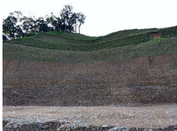
Foto 2-92: Proteção encostas na área de estudo com sistema de terraços e gramíneas. Fonte: Acervo Dossel, 2019.
