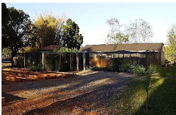
Foto 2-53: Visão geral da estrutura de um viveiro temporário. Fonte: Acervo Dossel, 2019.
