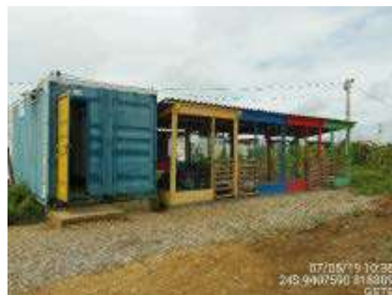
Foto 2-9: Baias para armazenamento temporário de resíduos afastado em local afastado e de fácil acesso. Fonte: Acervo CYMI, 2019.
