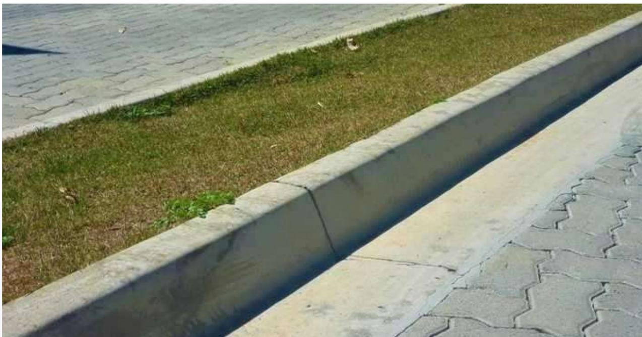
Sarjeta é uma placa de concreto de cimento Portland moldado ao longo da guia destinada a receber águas superficiais e conduzi-las a um coletor. A sarjeta tem as seguintes dimensões:
