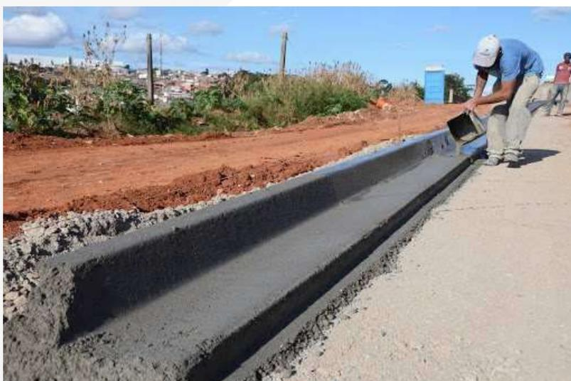
Juntas – a cada 7m será construída uma junta de contração por meio de uma seção enfraquecida com 5mm de largura e 50mm de profundidade.
