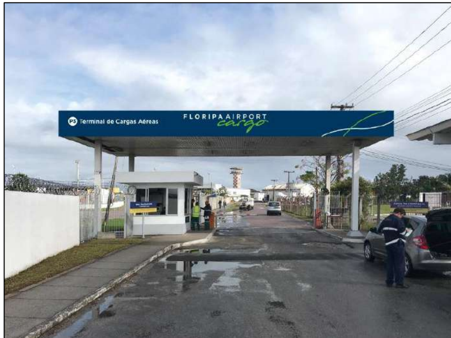
Figura 7: Terminal de cargas Floripa Airport Cargo. Fonte: MACARI, 2019.
