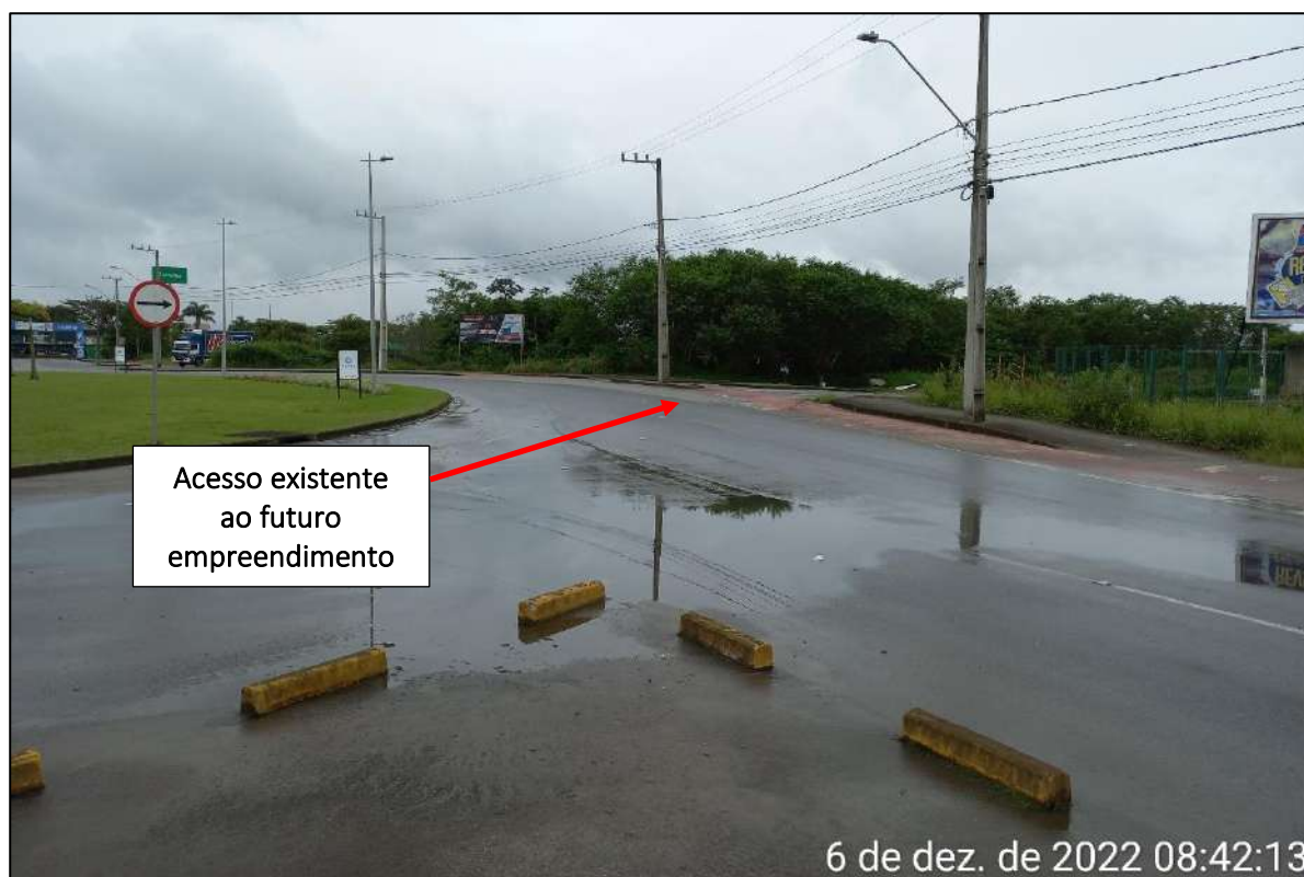
Figura 50: Acesso preparado para o futuro empreendimento. Fonte: Bioeco (2022).
