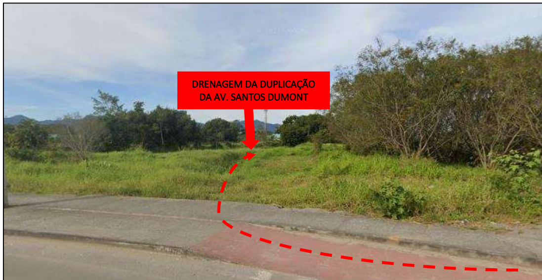
Figura 16: Momento em que a vala de drenagem proveniente da duplicação da Av. Santos Dumont converge a direita com o imóvel onde posteriormente faz confluência com a drenagem municipal (conforme Figura 33). Fonte: Bioeco, fotografia realizada no dia 15/03/2022.
