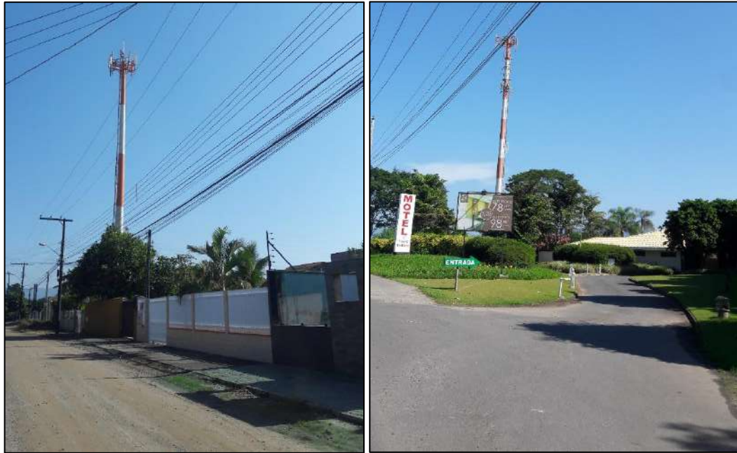
Figura 11: Torres de Telecomunicação localizadas na área de influência do empreendimento. Fonte: Bioeco Engenharia e Consultoria Ambiental (2020).
