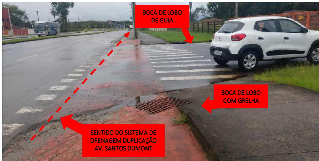
Figura 14: Bocas de lobo localizadas em frente ao Centro de Eventos Sítio Novo, responsáveis por contribuir com a vala de drenagem que se defronta com o terreno da área do imóvel. Fonte: Bioeco, fotografia realizada no dia 15/03/2022.
