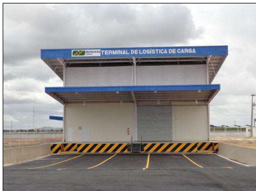
Figura 6: Terminal de Cargas do Aeroporto de Boas Vista (RR).
