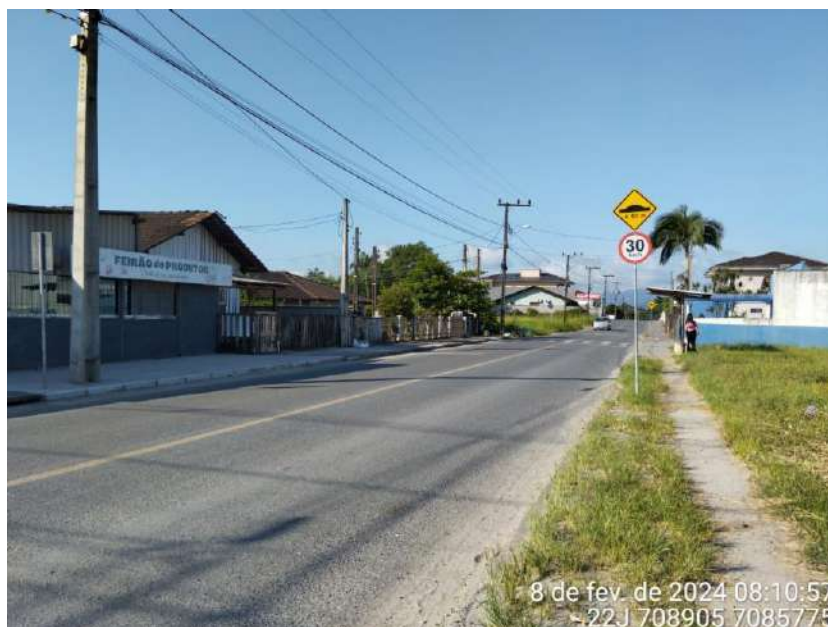
Figura 38: Postes de iluminação pública na rua Lagoinha, sentido rua Minas Gerais.
