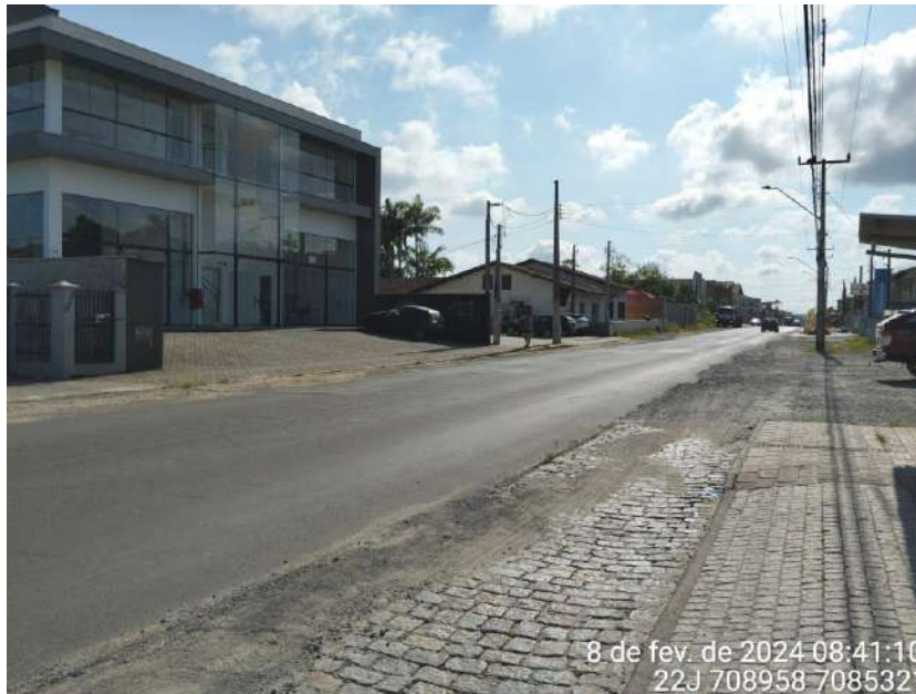
Figura 41: Postes de iluminação pública na rua Minas Gerais, sentido bairro Nova Brasília.
