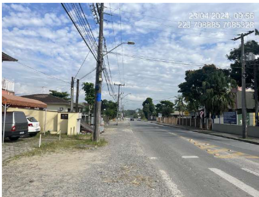
Figura 40: Postes de iluminação pública na rua Minas Gerais, sentido rua Lagoinha.
