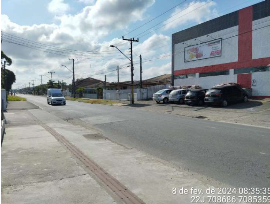
Figura 33: Boca de lobo na Rua Minas Gerais, em frente a empreendimento comercial Miquelute.
