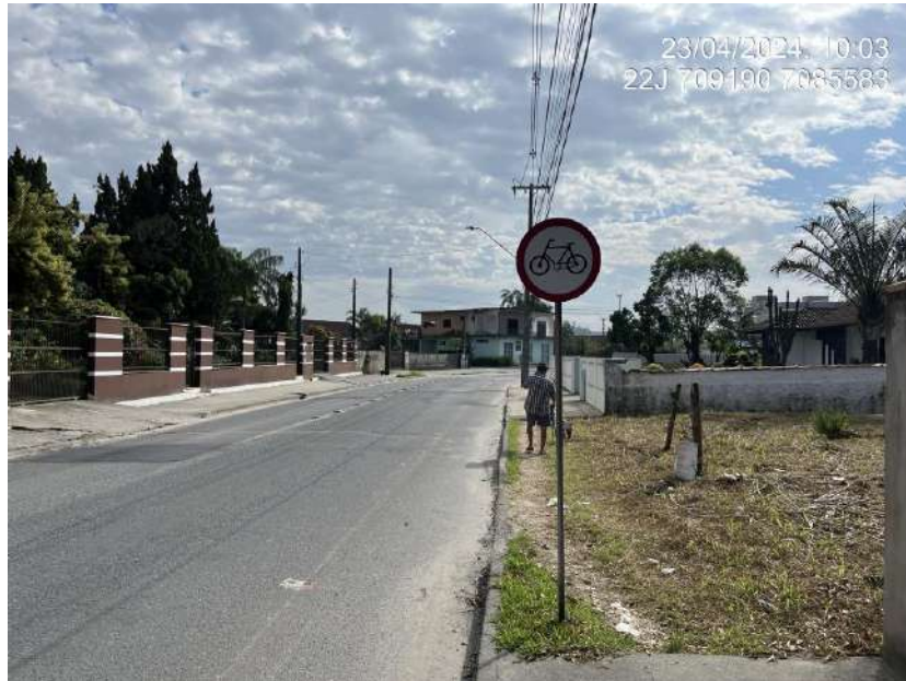
Figura 73: Ciclofaixa na rua Pitaguaras, com sinalização.
