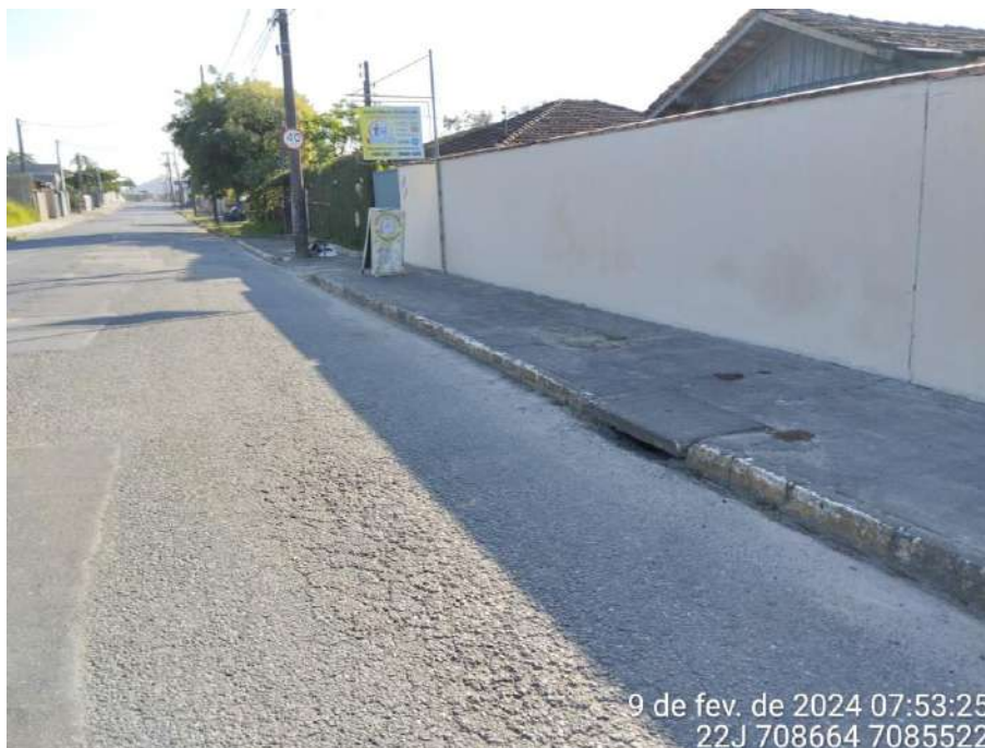
Figura 31: Boca de lobo em frente ao imóvel em estudo, rua Lagoinha.
