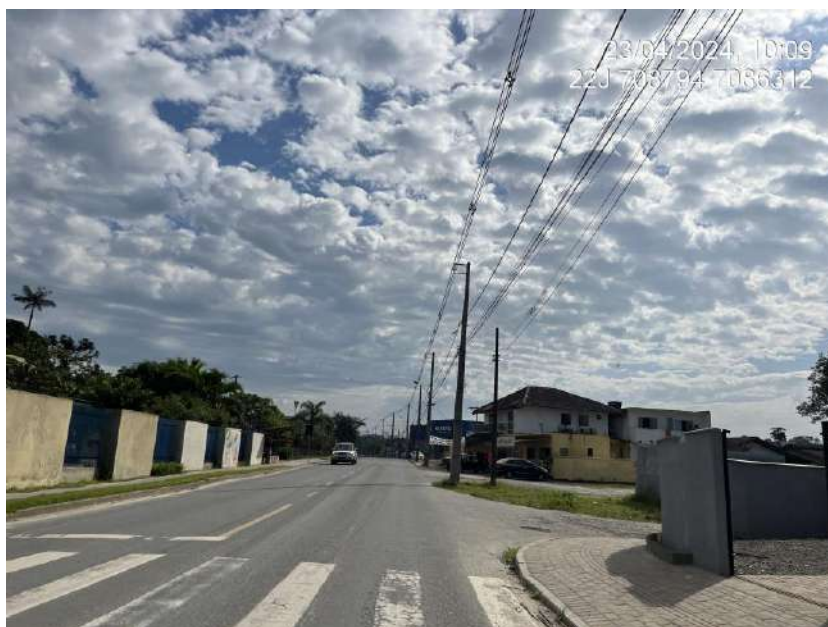
Figura 66: Rua Bernadete Uldrich, paralela à rua Lagoinha (em trecho que esta não é asfaltada).
