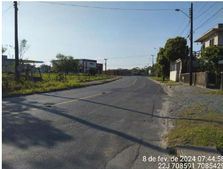
Figura 74: Sinalização na rua Lagoinha, trecho inicial, vista para rua Minas Gerais.
