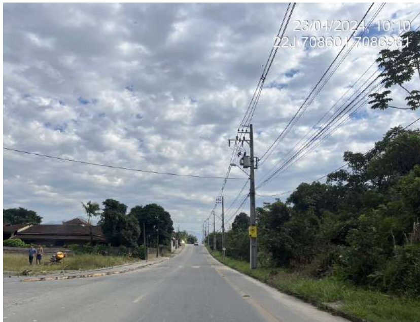
Figura 63: Ciclofaixa na Estrada Barbante; calçada em obras de pavimentação do lado oposto, esquina com a rua Tancredo Neves.
