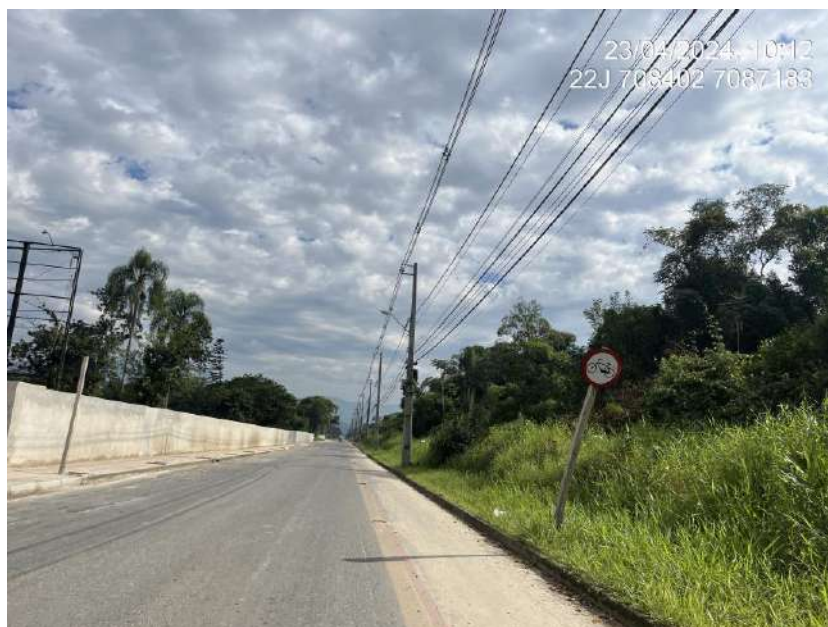
Figura 62: Ciclofaixa na Estrada Barbante; calçada pavimentada do lado oposto.
