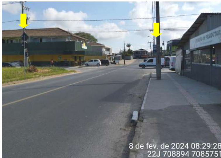
Figura 76: Sinalização na rua Lagoinha, sentido estrada Barbante, intersecção com rua Antonio Alves.
