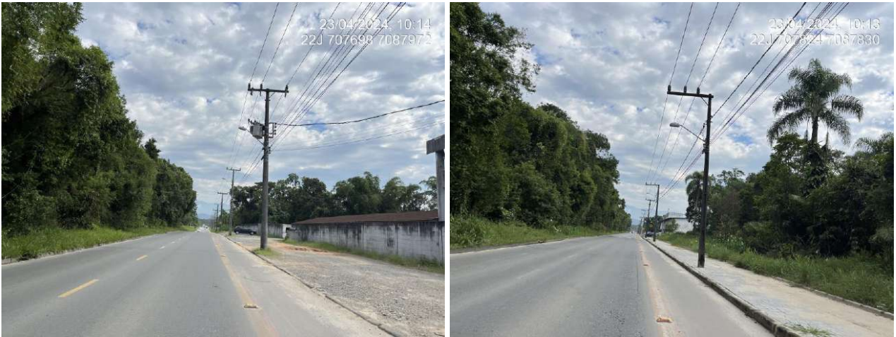
Figura 17: Estrada Barbante, vista para rodovia; trecho com calçada não pavimentada (esq.) e pavimentada (dir.).
