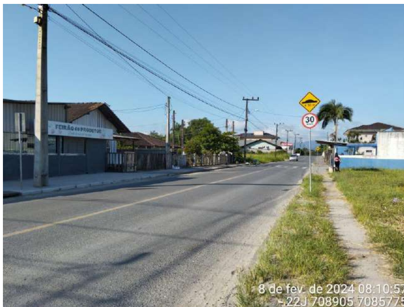
Figura 15: Rua Lagoinha, próximo à UBS Local, com calçada parcialmente pavimentada, porém, possibilitando acesso dos pedestres.
