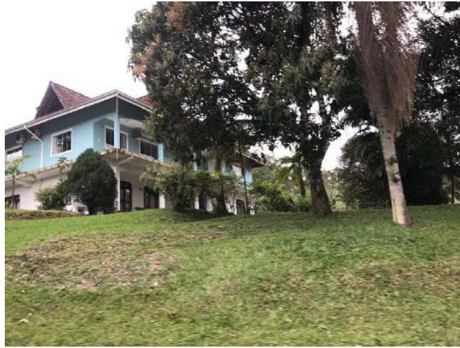
Foto 60 – Edificação vizinha – Rua Santa Catarina – sentido norte-sul.
