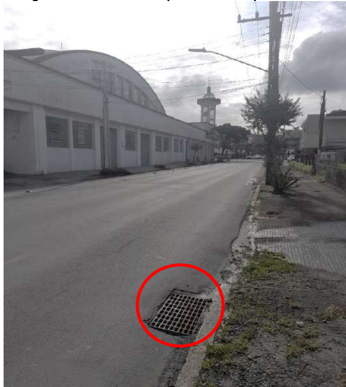
Figura 12 - Boca de lobo próxima ao empreendimento
