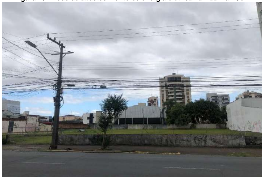
Figura 15 - Rede de abastecimento de energia elétrica na Rua Max Colin
