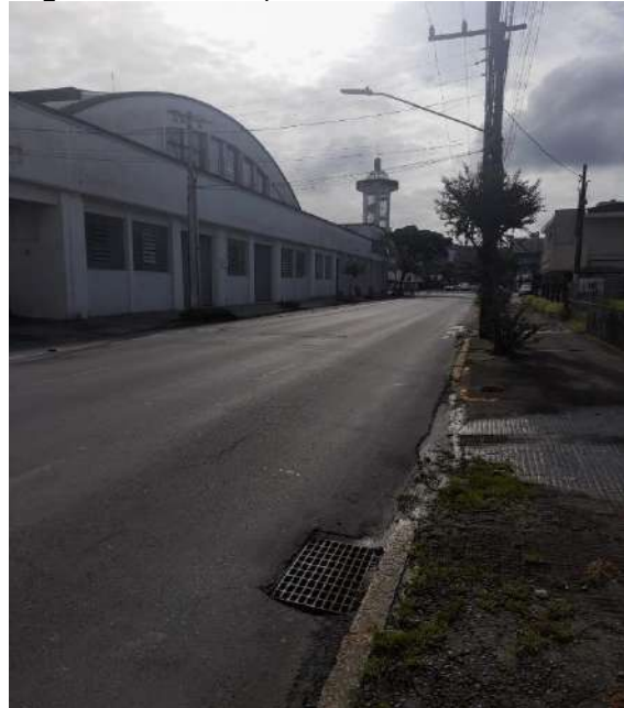
Figura 35 - Sinalização horizontal Rua Max Colin
