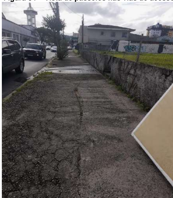
Figura 34 – Vista de passeios nas vias de acesso
