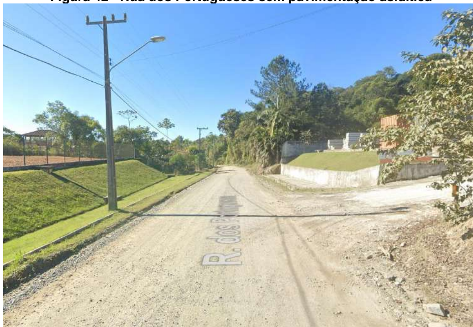
Figura 42 - Rua dos Portugueses sem pavimentação asfáltica
