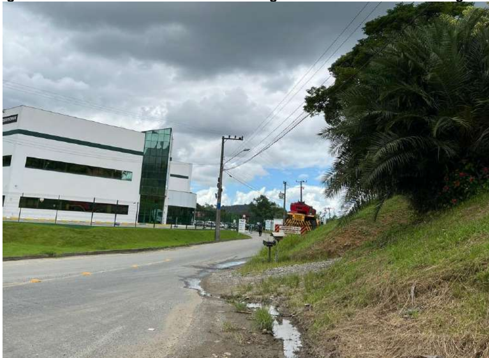
Figura 39 - Rede de abastecimento de energia elétrica na Rua dos Portugueses
