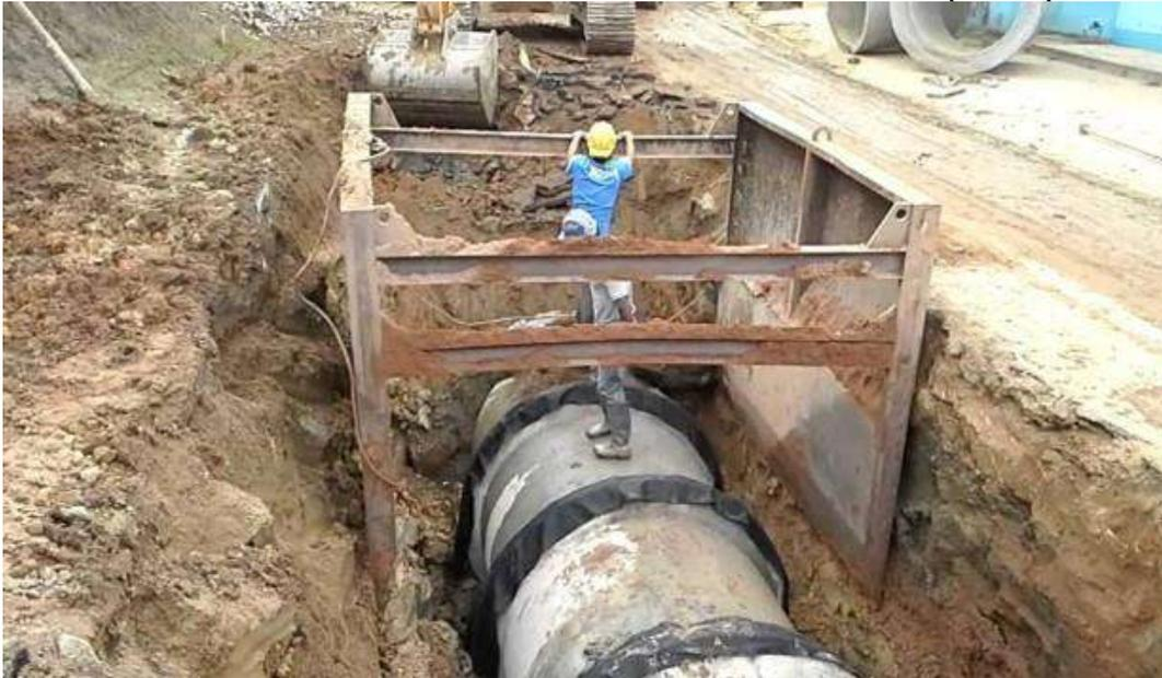
As tensões as quais a blindagem está submetida estão associadas ao empuxo ativo mobilizado no solo escavado, assim como a sobrecargas nas imediações. Considerando uma vala com profundidade de 2,50 m escavada em solo com as propriedades geotécnicas previamente apresentadas, comprimento escorado de 3,00 m e sobrecarga de 20 kPa, o empuxo ativo resultante equivale a 159,61 kN.
