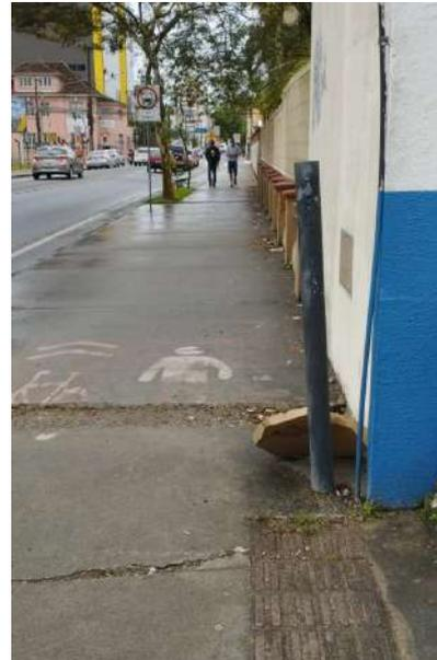
Calçada com rompimento do concreto para passagem de infraestrutura e sem recomposição. Piso tátil direcional para continuidade em guia de parede, porém pilar metálico obstrui a passagem para a pessoa com deficiência visual.
