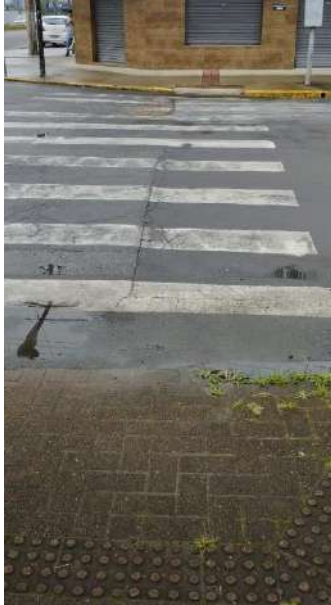
Rebaixo de calçada para travessia da Rua Coronel
