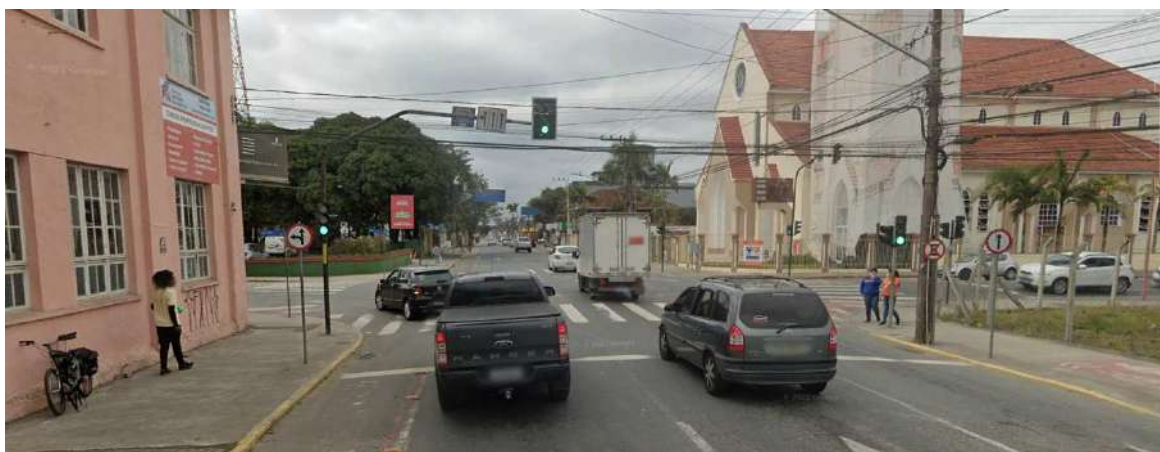
Figura 4.15 - Interseção Semafórica da Rua Inácio Bastos com Rua São Paulo. Fonte: Google Earth.
