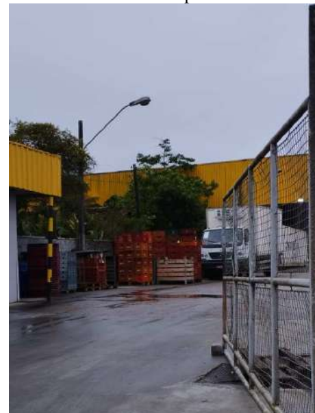
Iluminação na área interna do empreendimento. Na atual área de docas.
