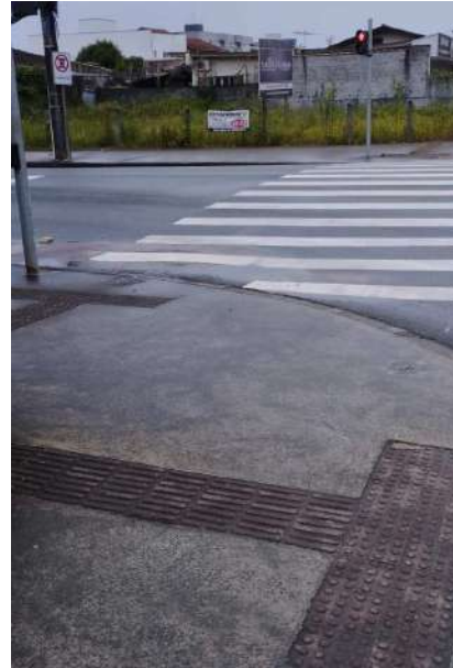
Acessibilidade com piso tátil direcional na esquina e calçada com inclinação adequada.
