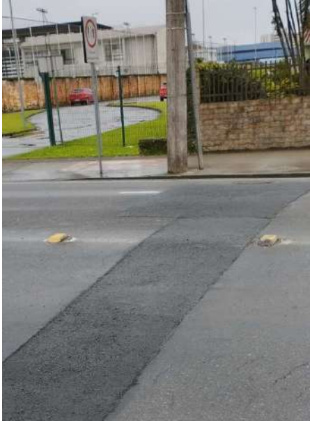
Capa asfáltica posterior pavimentação original, para provável manutenção de infraestrutura enterrada.
