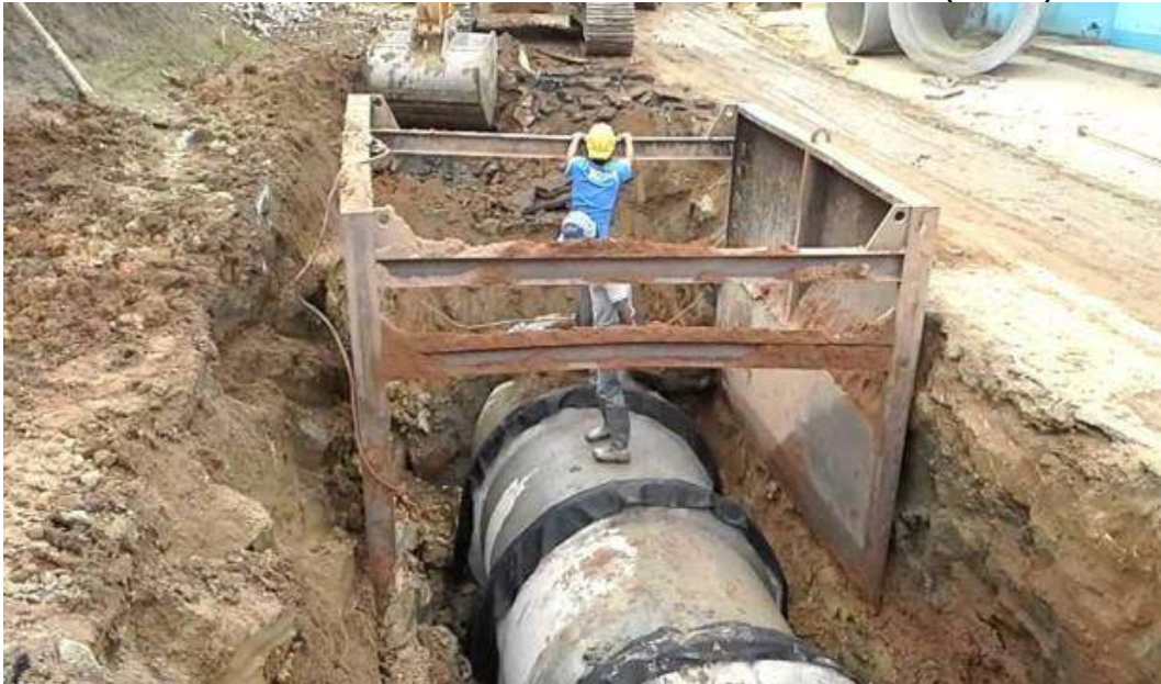
FIGURA 4 – ESCORAMENTO DESCONTÍNUO COM BLINDAGEM PESADA (GAIOLA).
