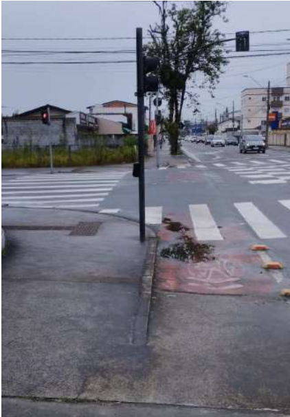
Rebaixo na calçada para pedestres e ciclistas em cruzamento das vias, com sinalização em bom estado.
