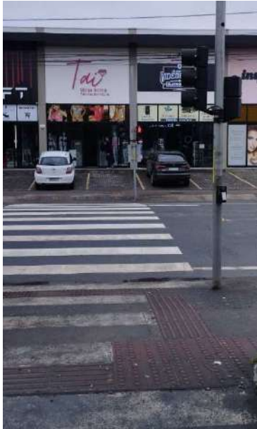
Piso tátil direcional e alerta conforme norma NBR 9050, com rebaixo de calçada em inclinação adequada, para travessia de pedestres em local semaforizado.
