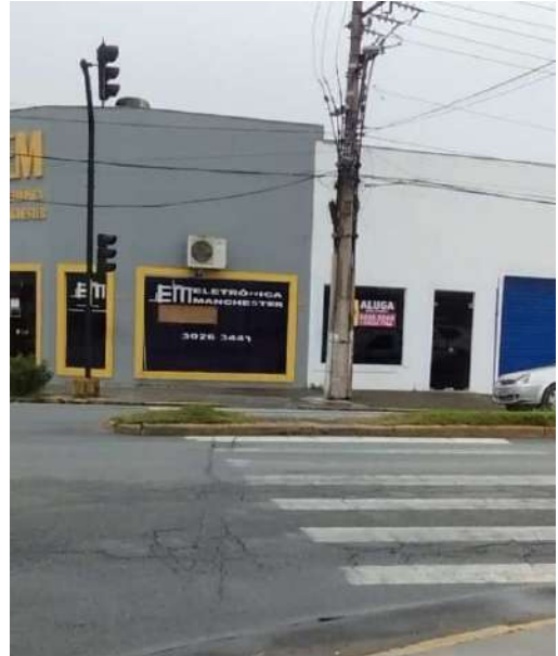
Esquina da Rua Coronel com Av. Procópio Gomes não possui rebaixo no canteiro central da avenida para acessibilidade na travessia.
