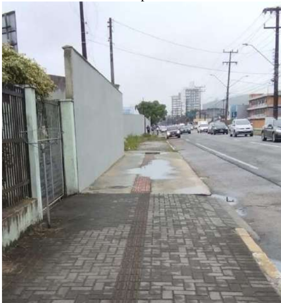
Calçada com piso tátil direcional.
