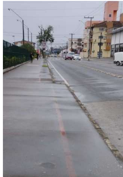
Pavimento asfáltico e calçada em boas condições
