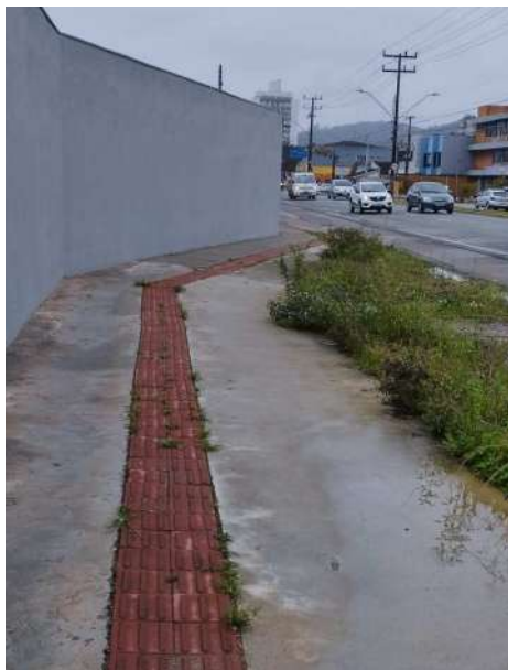
Piso tátil e calçada em boas condições na frente do Fort. Área com vegetação será pavimentada
