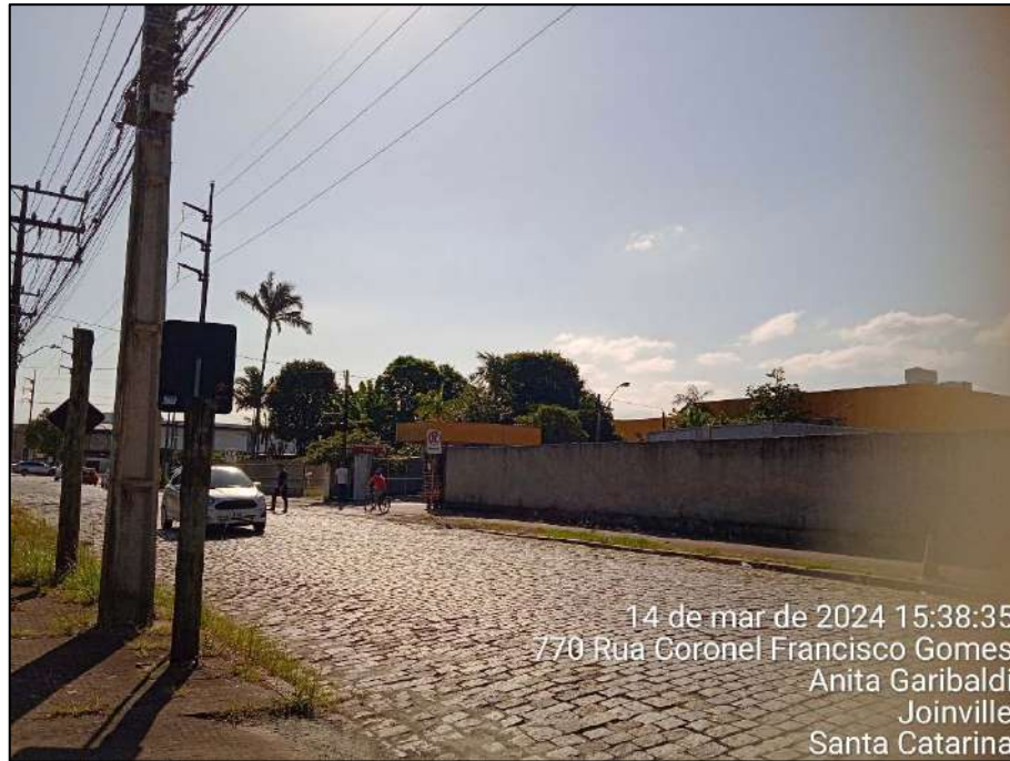
Figura 4.4 - Acesso atual das docas
