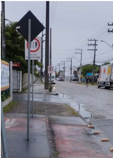
Rebaixo de ciclovia e sinalização na via
