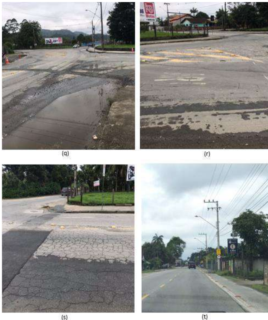
Figura 48 – (q), (r) e (s) Sinalização Horizontal da Rotatória e (t) Ciclofaixa, pintura da faixa de rolamento e sinalização vertical da Estrada da Ilha;
