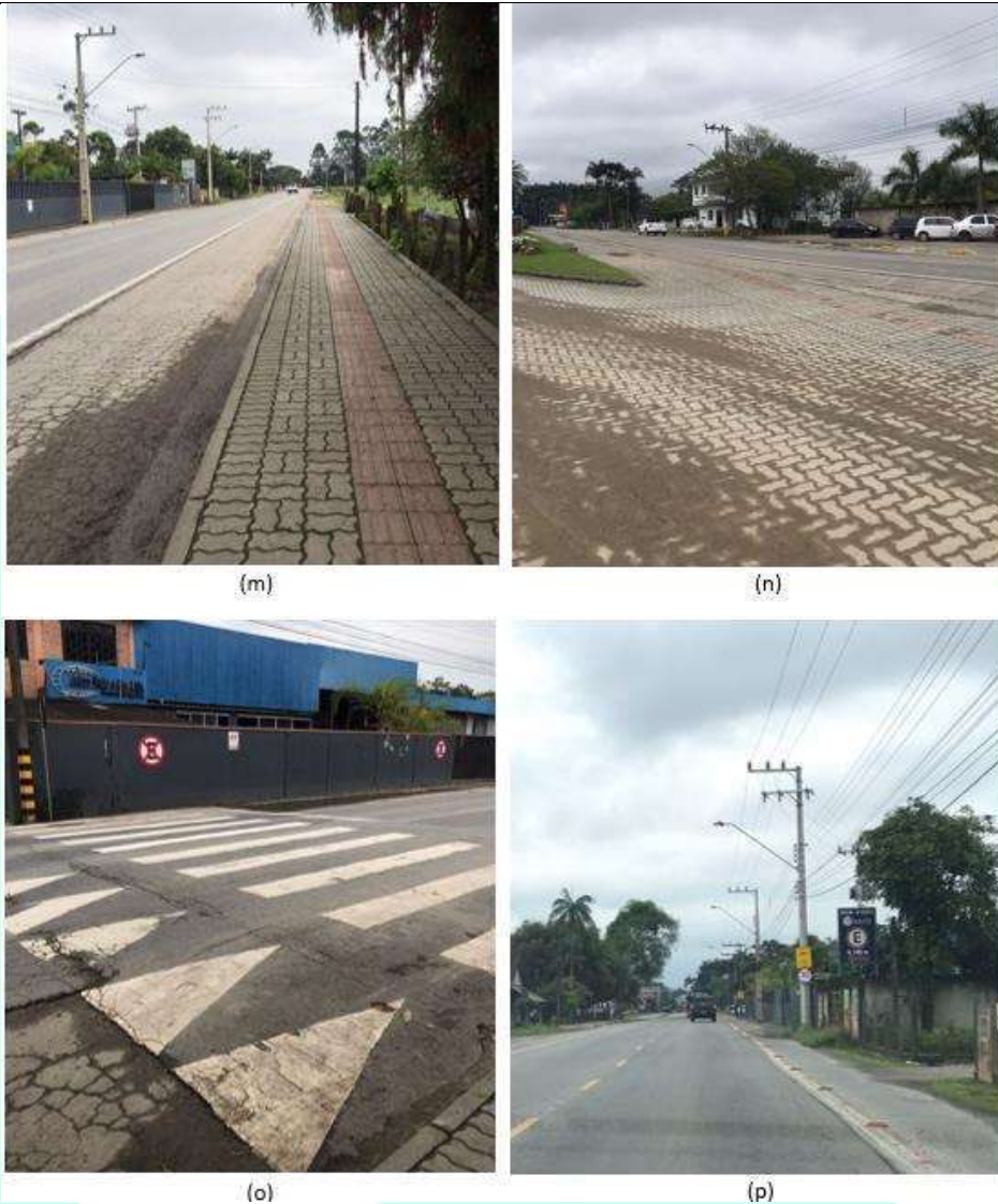
Figura 65 – (m) e (n) Passeio com piso tátil no lado direito, (o) Faixa elevada para travessia de pedestres em frente ao empreendimento e (p) Ciclofaixa no lado esquerdo;
