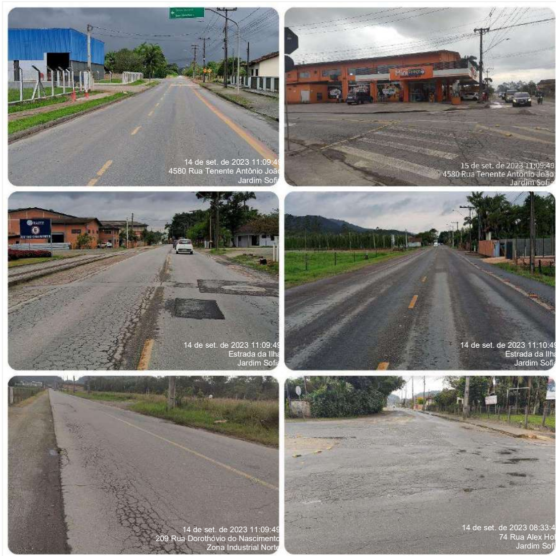
Figura 8: Vias principais de acesso ao empreendimento.
