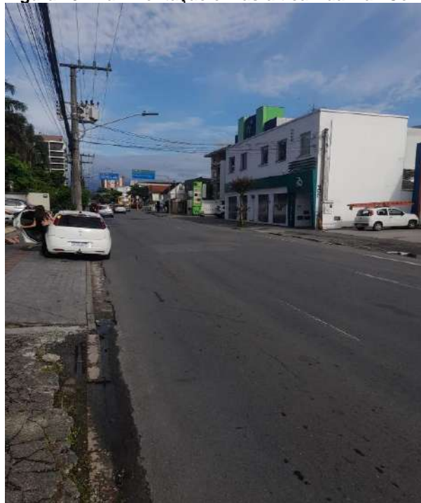
Figura 10 - Pavimentação em asfáltica Rua Max Colin
