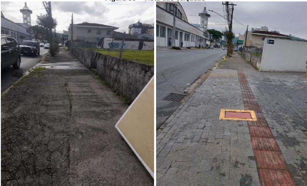
Figura 36 – Vista das calçadas
