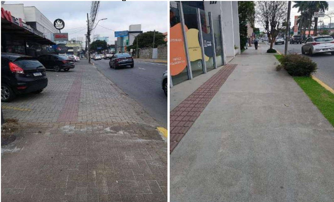
Figura 38 - Vista das calçadas
