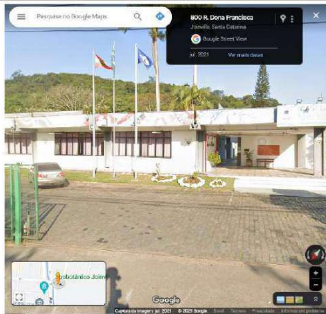
Figura 70. Imóvel tombado, Rua Dona Francisco, 800. Fonte: Google Maps, em 01/10/2023.
