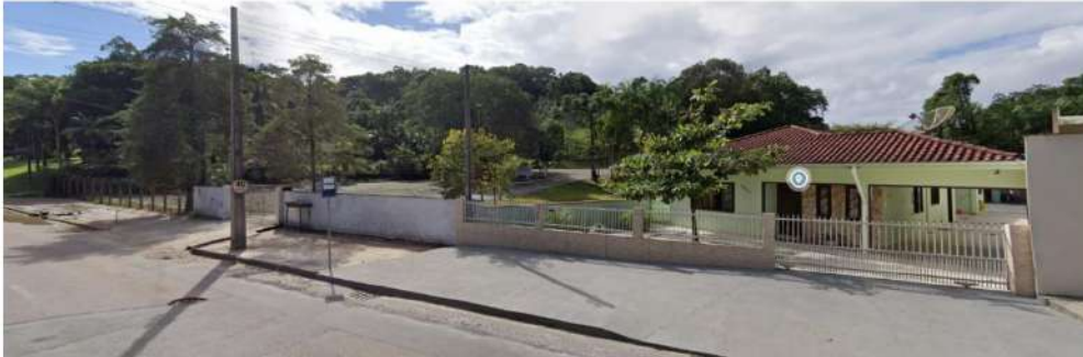
Foto 61 – Edificação vizinha – Rua Santa Catarina – sentido sul-norte.
