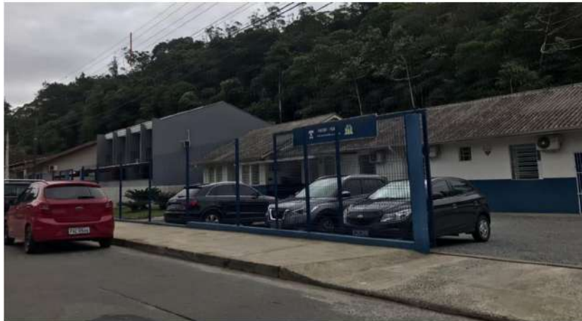
Figura 21 – Unidade básica de Saúde UBSF KM 4 - mais próxima ao empreendimento.
