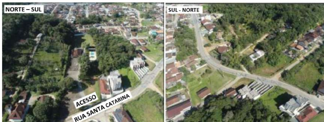
Figura 57 - Volumetria das edificações no entorno e Acesso ao terreno pela Rua Santa Catarina.
